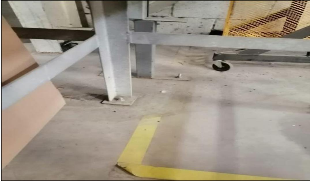
*Ilustración 4.8 Fijación De Maquinaria*
